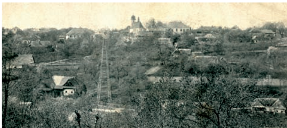
Před chalupou č.43, větrné kolo pohánějící od r. 1902 - 1925 čerpadlo vytlačující vodu z pramene do rezervoaru za školou
